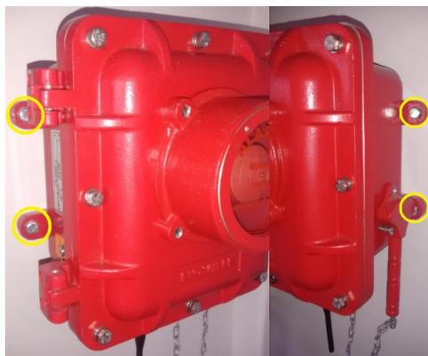
Figura 20 - Localização dos pontos de fixação do lado esquerdo e direito da WBAEXE.
