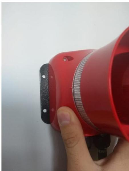
Figura 15 - Posicione o dispositivo, faça as marcações e realize as furações.
