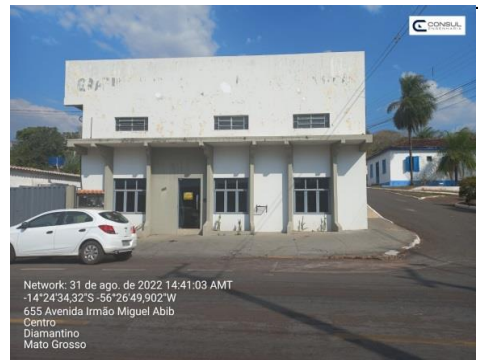
Fachada Vizinho Frontal
