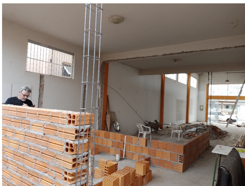
Figura 17 – Vista interna da edificação do imóvel avaliando (sala 02).
