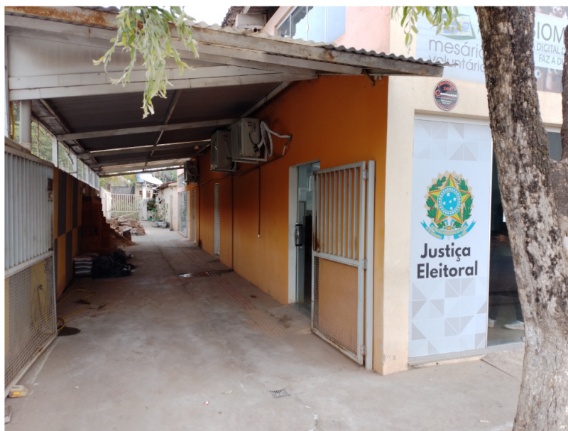
Figura 9 – Vista da lateral esquerda da edificação do imóvel avaliando.
