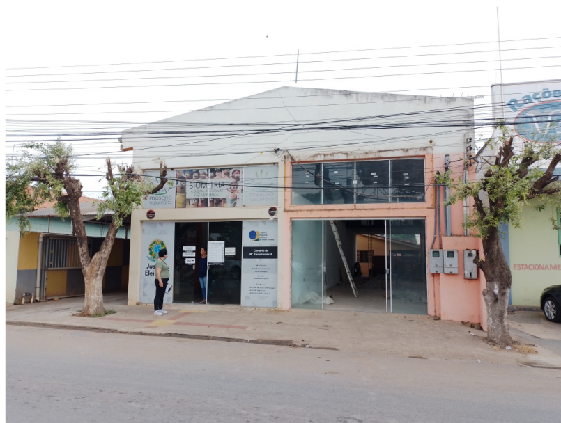
Figura 4 – Vista geral do imóvel avaliando.
