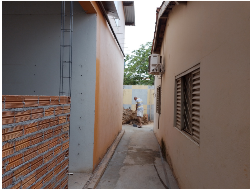
Figura 10 – Vista dos fundos da edificação do imóvel avaliando.
