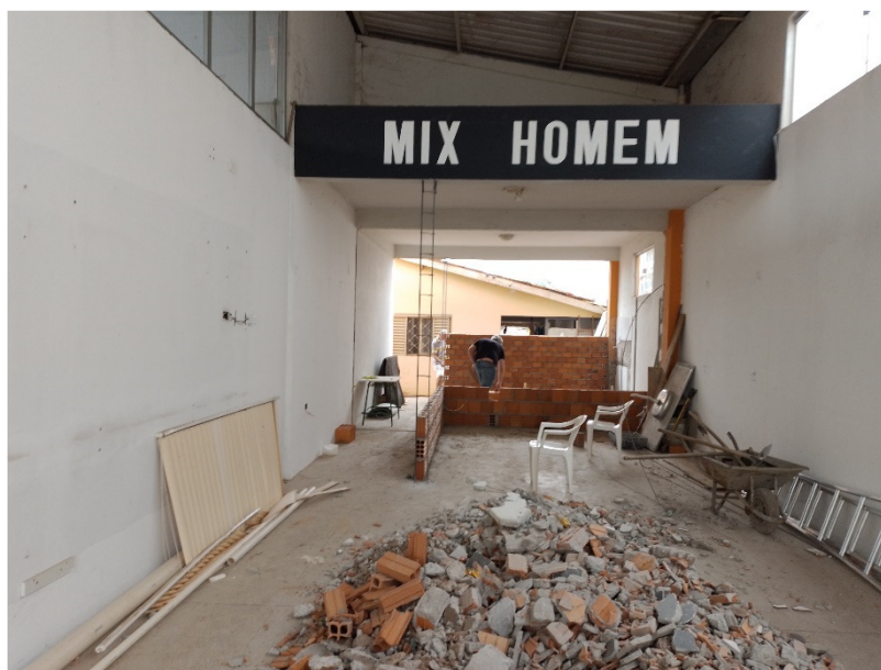
Figura 16 – Vista interna da edificação do imóvel avaliando (operacional, sala 02).
