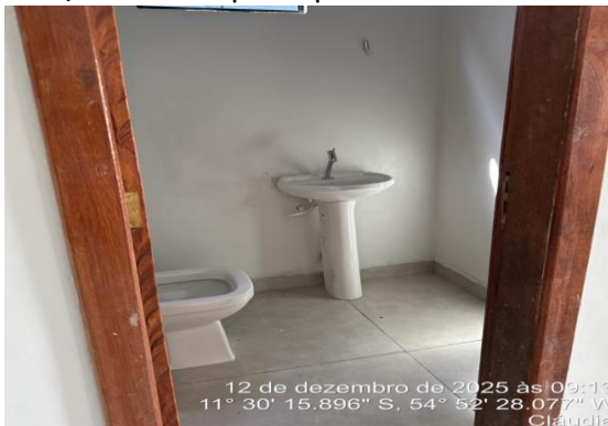
15. Ambiente interno – banheiro
