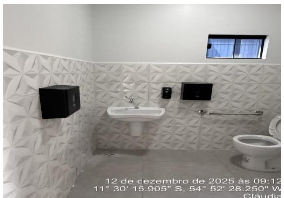
22. Ambiente interno – banheiro
