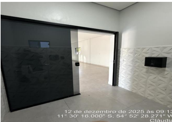
19. Ambiente interno – porta de acesso / divisória
