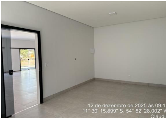
13. Ambiente interno – acesso a sala/ambiente principal
