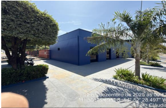
1. Fachada principal do imóvel avaliado
