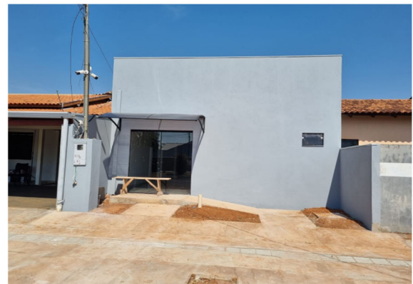
4 - Ampliação da fachada lateral
