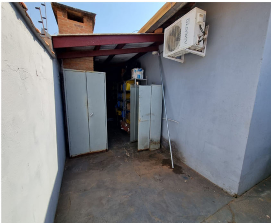
27- Detalhe da área externa técnica
