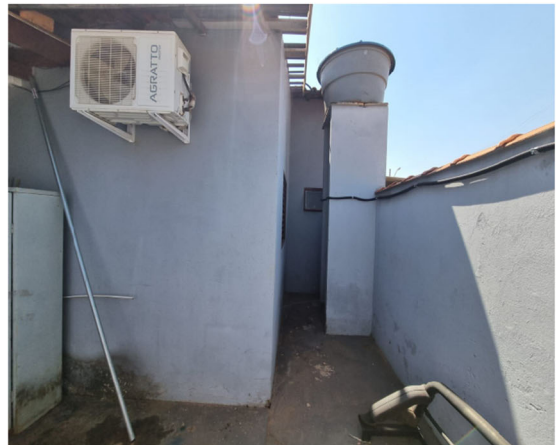
28- Detalhe da área externa técnica
