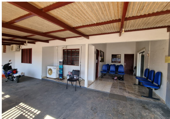
7 - Área de espera coberta
