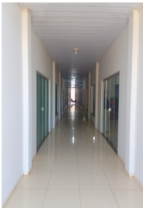
Figura 9 – Circulação interna do edifício comercial.
