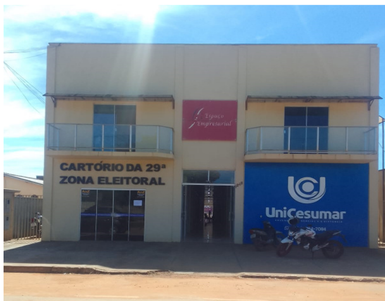
Figura 4 – Vista geral do imóvel avaliando.
