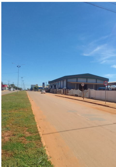
Figura 6 – Localização do imóvel avaliando com vista para a Av. Siegfried Buss
