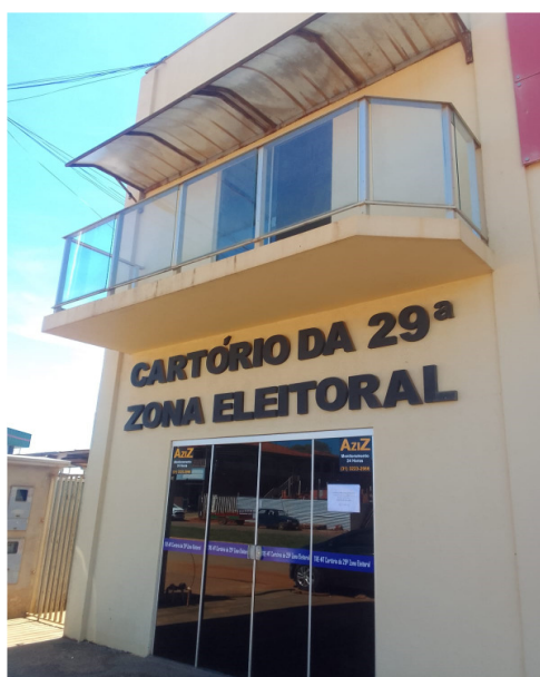
Figura 7 – Fachada Frontal do imóvel avaliando.
