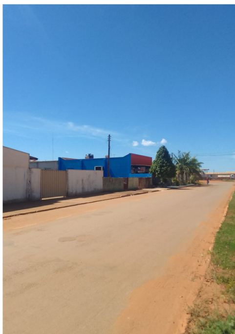
Figura 5 – Localização do imóvel avaliando com vista para a Av. Siegfried Buss
