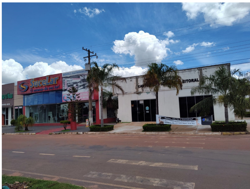
Figura 4 – Vista geral do imóvel avaliando.
