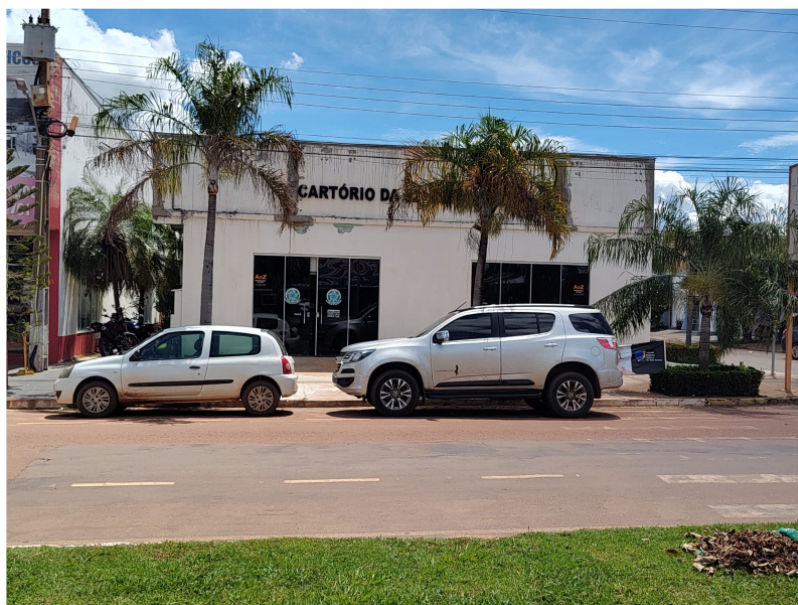
Figura 7 – Fachada Frontal do imóvel avaliando.
