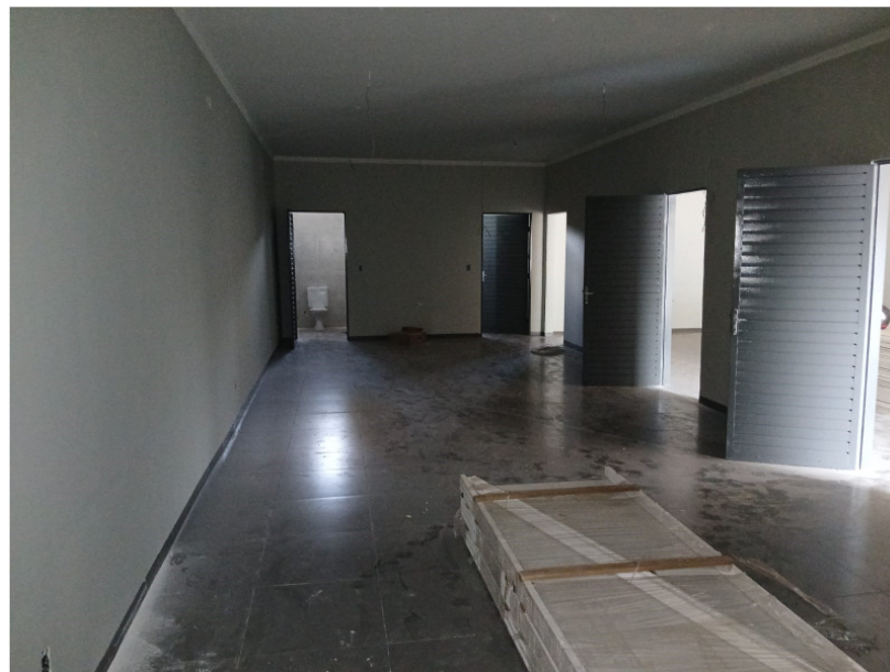
Figura 11 – Vista interna da edificação do imóvel avaliando (Copa).
