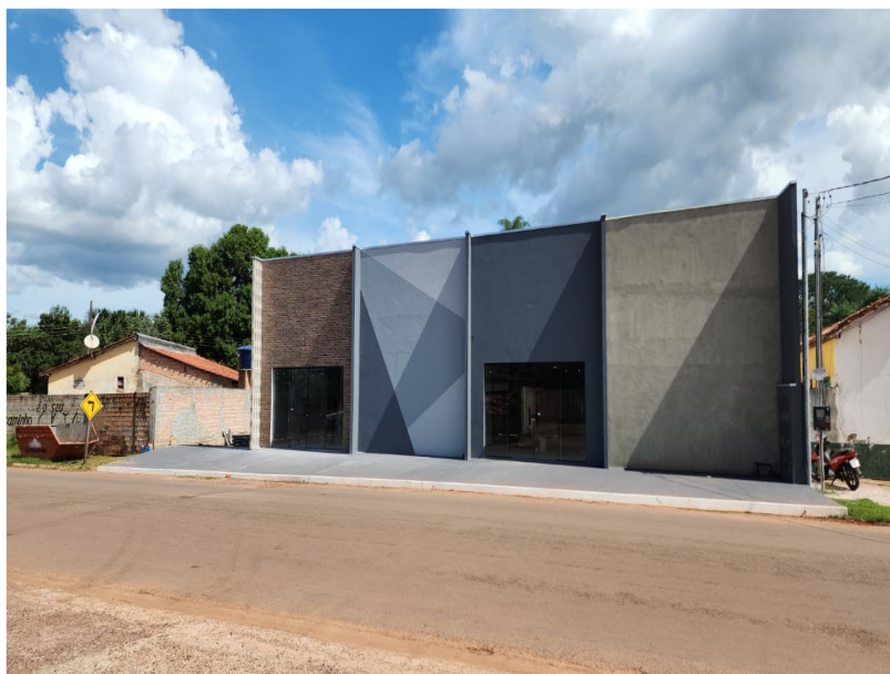
Figura 4 – Vista geral do imóvel avaliando.
