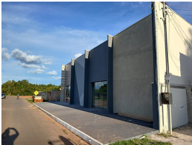
Figura 8 – Vista da lateral direita da edificação do imóvel avaliando.
