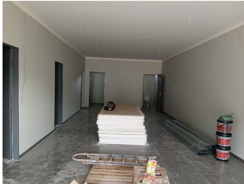
Figura 10 – Vista interna da edificação do imóvel avaliando. (vista para a entrada)
