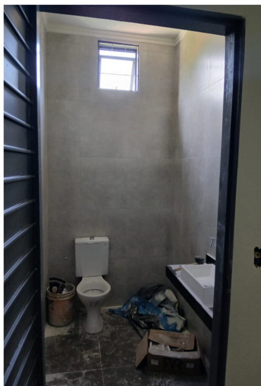
Figura 13 – Vista interna da edificação do imóvel avaliando (WC 02).
