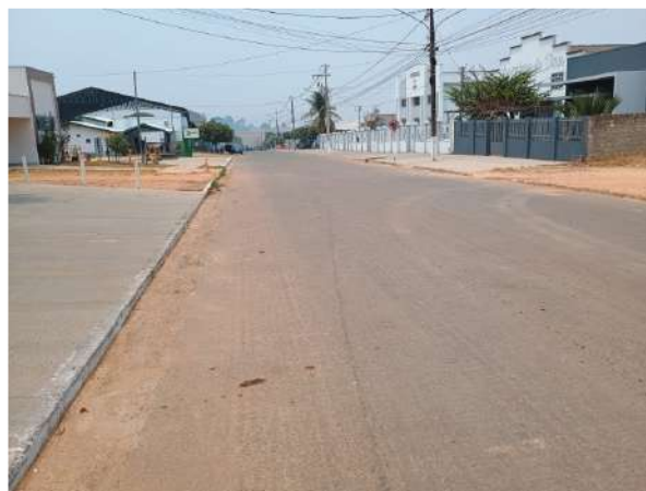
Figura 6 – Vista 2 da rua principal de acesso
