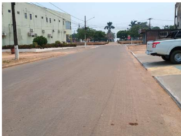
Figura 5 – Vista 1 da rua principal de acesso
