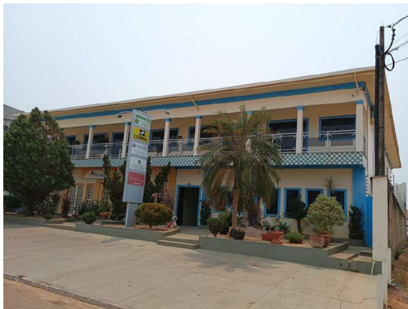
Figura 7 – Fachada Frontal do imóvel avaliando.
