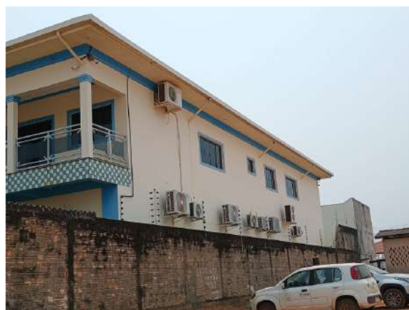
Figura 9 – Lateral esquerda da edificação.
