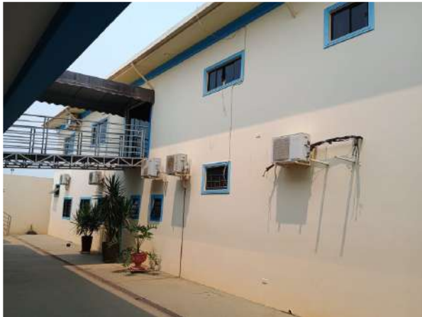
Figura 10 – Vista dos fundos da edificação.
