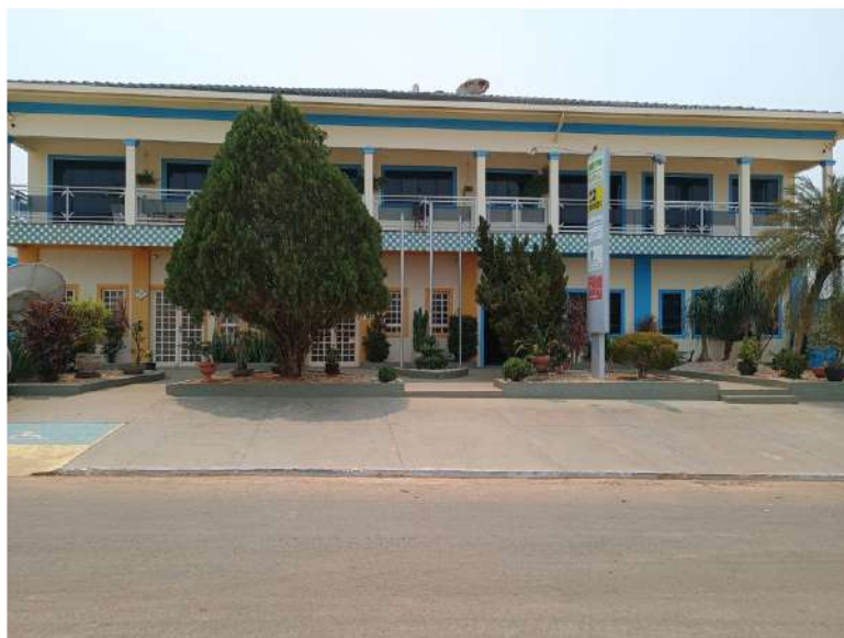
Figura 4 – Vista geral do imóvel avaliando.
