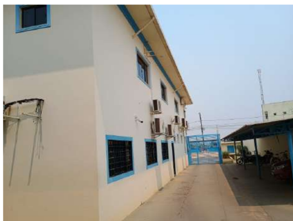
Figura 8 – Lateral direita da edificação.
