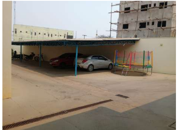
Figura 11 – Vista geral do pátio.
