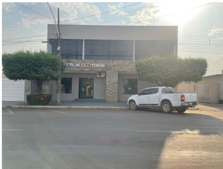
Figura 4 – Vista geral do imóvel avaliando.
