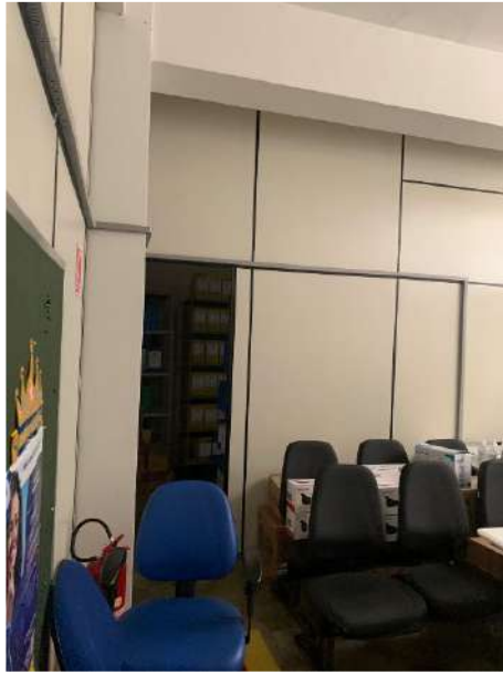
Figura 18 –Vista interna (atendimento)
