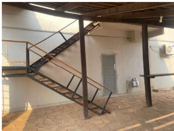
Figura 10 – Vista dos fundos da edificação.
