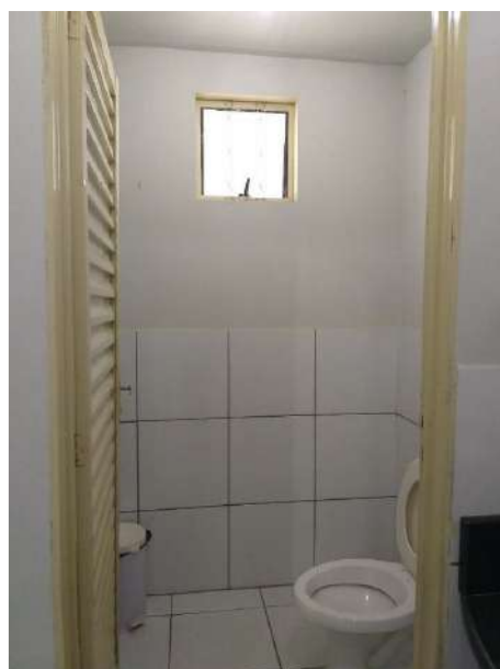
Figura 24 –Vista interna (WC 02)
