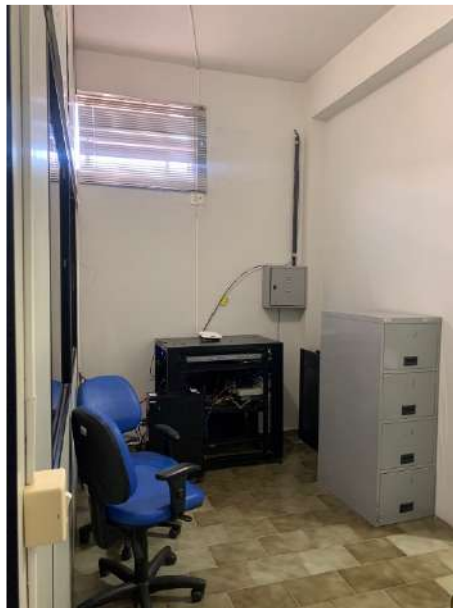
Figura 15 –Vista interna (sala 01)
