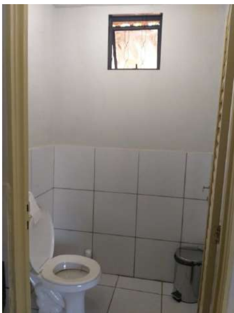
Figura 16 –Vista interna (WC 1)
