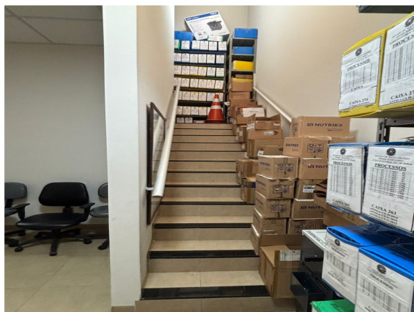
Figura 10 – Vista interna da edificação (Escada).
