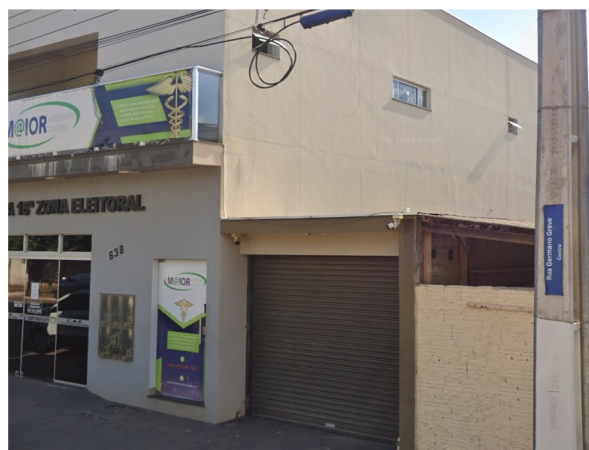
Figura 9 – Lateral esquerda da edificação.
