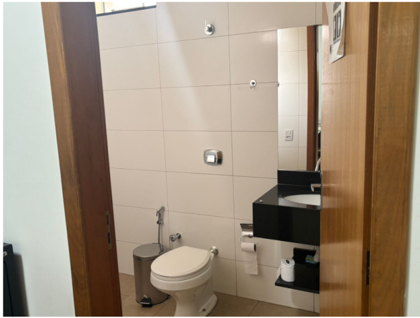
Figura 16 –Vista interna (WC 1)
