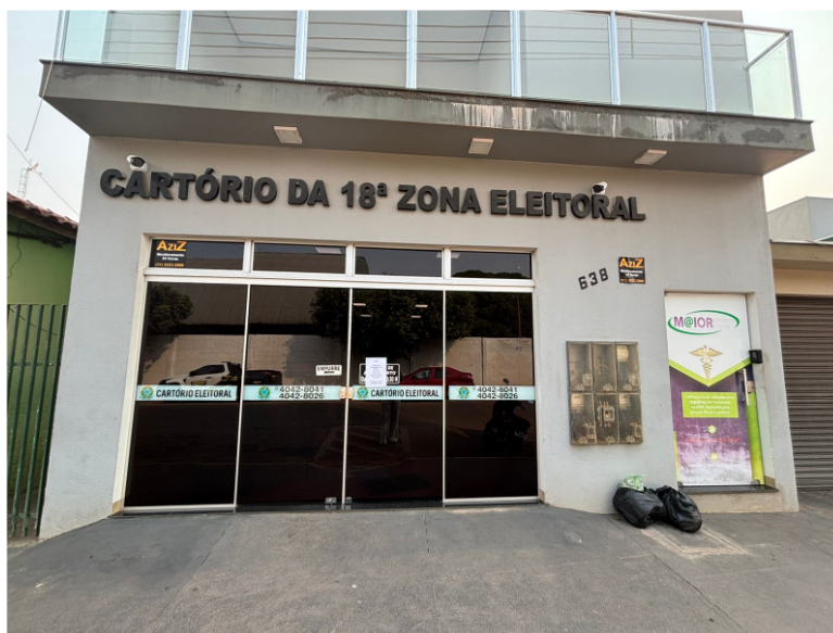
Figura 4 – Vista geral do imóvel avaliando.
