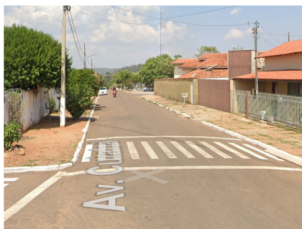
Figura 6 – Vista 2 da rua principal de acesso
