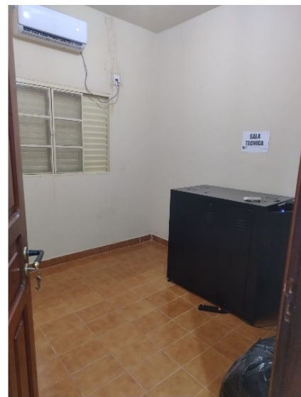
Figura 17 –Vista interna (sala 01)
