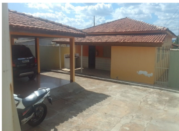
Figura 08 – Vista dos fundos da edificação.
