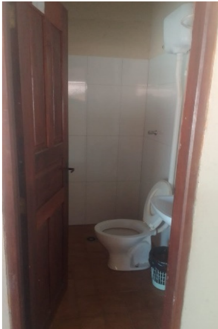
Figura 14 –Vista interna (WC 1)
