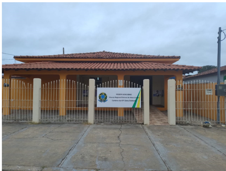
Figura 4 – Vista geral do imóvel avaliando.
