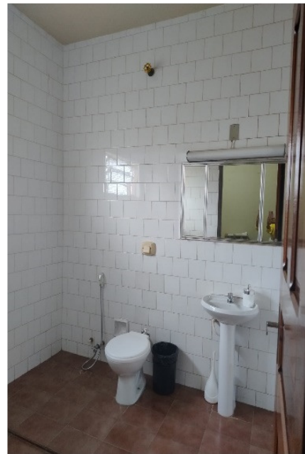
Figura 15 –Vista interna (WC 2)
