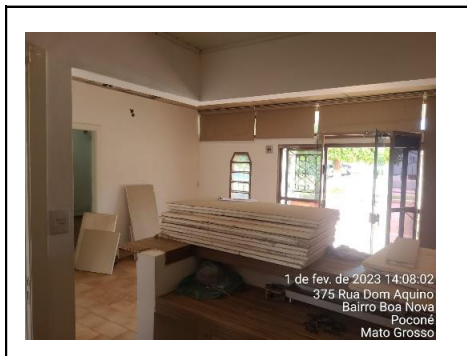
RECEPÇÃO SALA - SALA DE ESPERA
