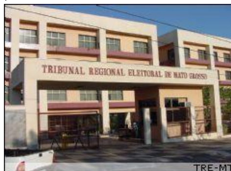
Prédio-sede do TRE/MT
