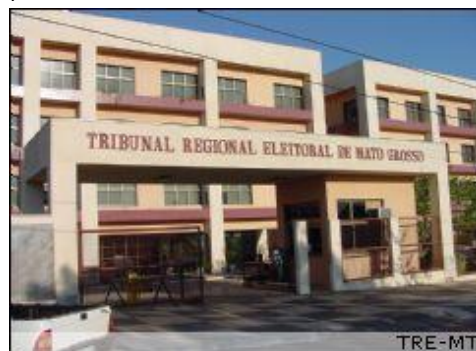
Prédio-sede do TRE/MT
